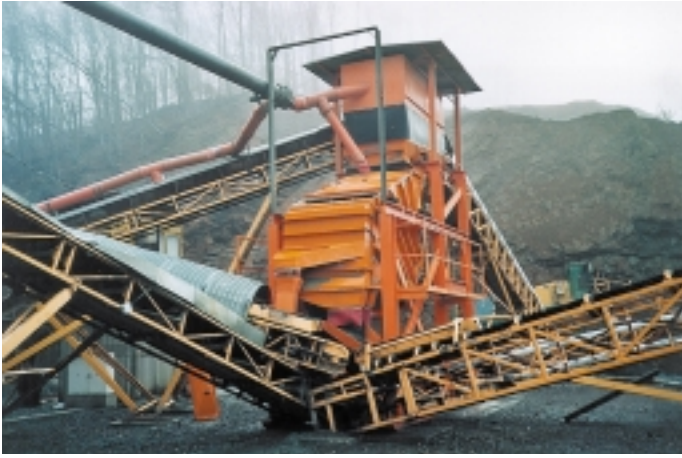
Bild 4: Betonwerk Lučka, 1. Siebstufe mit Sizer SL 1546 und Abzugsbändern
